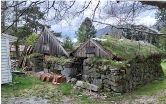
Fjøs Vølstad, gnr. 18 - bnr. 33 Fjøset er antatt bygget i 1822. Det er bygget i tørrmur og har autentisk grunn- og planform. Skillene mellom båsene er de opprinnelige steinhellene. Denne delen av fjøset ligger noe høyere enn hevdafjøset i den andre enden av bygningen. Det er både dør og luke mellom de to fjøsdelene. Denne typen fjøs peker tilbake på folkevandringstiden med paralleller til bl.a. Island og Hebridene. Regulert til spesialområde bevaring Tilstand: Sterkt truet
