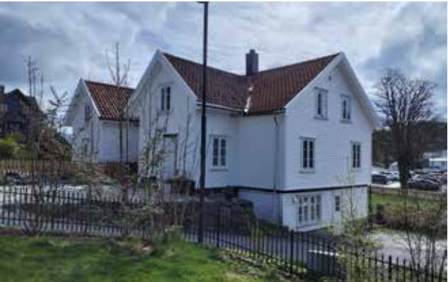
Bolighus Nilsabakken 2 gnr. 7 - bnr. 666 Boligen er oppført i 1890 av Aalgaards Uldvarefabrikk A/S (senere DFU). Bygget var opprinnelig bolig for arbeidere. Huset har saltak, 1 ½ etasje og liggende tre-kledning. Boligen har tilnærmet autentisk grunnform. Bygningen har særlig høy verneverdi fordi den ligger i tilknytning til andre bygninger fra samme epoke som også ble oppført av DFU. Boligen har vært lærerbolig med sløydsl i kjelleren. Bygningen er regulert til spesialområde bevaring Tilstand: God
