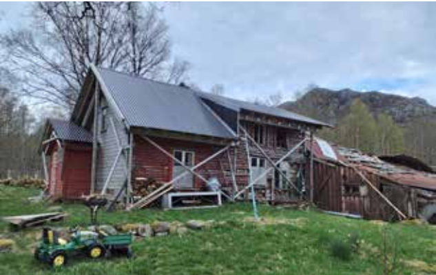
Sammenbygget våningshus, løe og stall Slettabø, gnr. 19 - bnr. 33 Bolighuset er laftet mens stall og løe har grindkonstruksjon. Bygningen er fra om lag 1850. Har vært det eneste sammenbygde huset i Gjesdal. Taket i løedelen har falt ned og denne delen av bygningen er vurdert som tapt. Enkelte grunder i kontstruksjonen står fremdeles. Tilstand: Sterke truet
