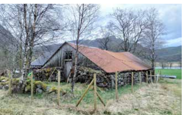
Fjøs Slettabø, gnr. 19, bnr. 33 Fjøset er antatt bygget rundt 1850. Det er todelt, med en lavere og en høyere del, og er bygget i tørrmur. Grunnformen er autentisk, men det ble lagt på nytt bølgeblikktak rundt 1950. Tilstand: Behov for restaurering
