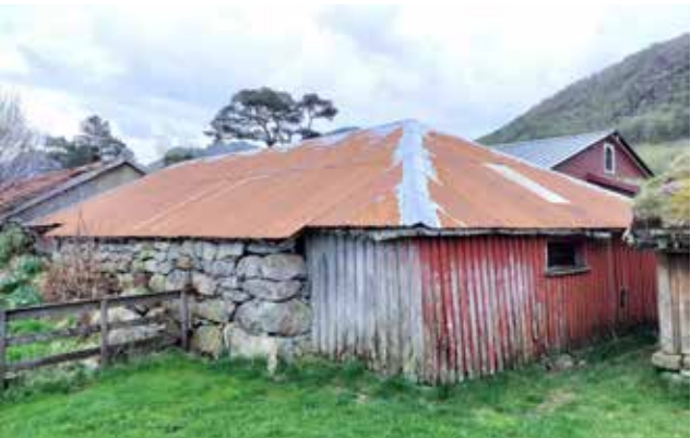
Fjøs Haugamork ”Sauahuset”, gnr. 15 - bnr. 1 Fjøset er antatt bygget på siste del av 1800-tallet, både i tørrmur og laft. Det laftede fjøset ligger noe høyere enn hevdafjøset i stein, og det er både dør og luke mellom de to delene. Taket er valmet og var opprinnelig i torv. Tilstand: God
