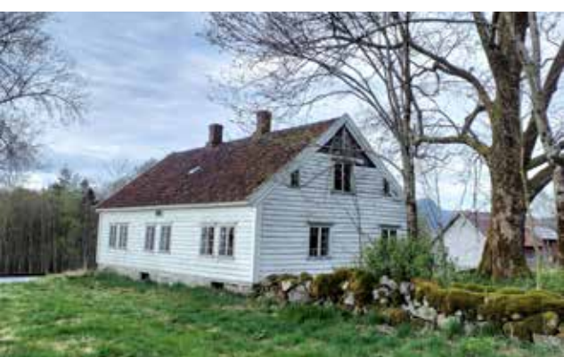
Våningshus, Kluge, gnr. 28 - bnr. 2 Boligen er oppført i 1847. Midtgangs-huset har saltak med rød teglstein, to piper i rød tegl og liggende trekledning. Det er 1 ½ etasje og kjeller under halve huset. Tunet hadde tidligere flere uthus – smie, uthus for sau, maskinløe og stabbur. Grunnform og eksteriør er autentisk. Tilstand: Truet
