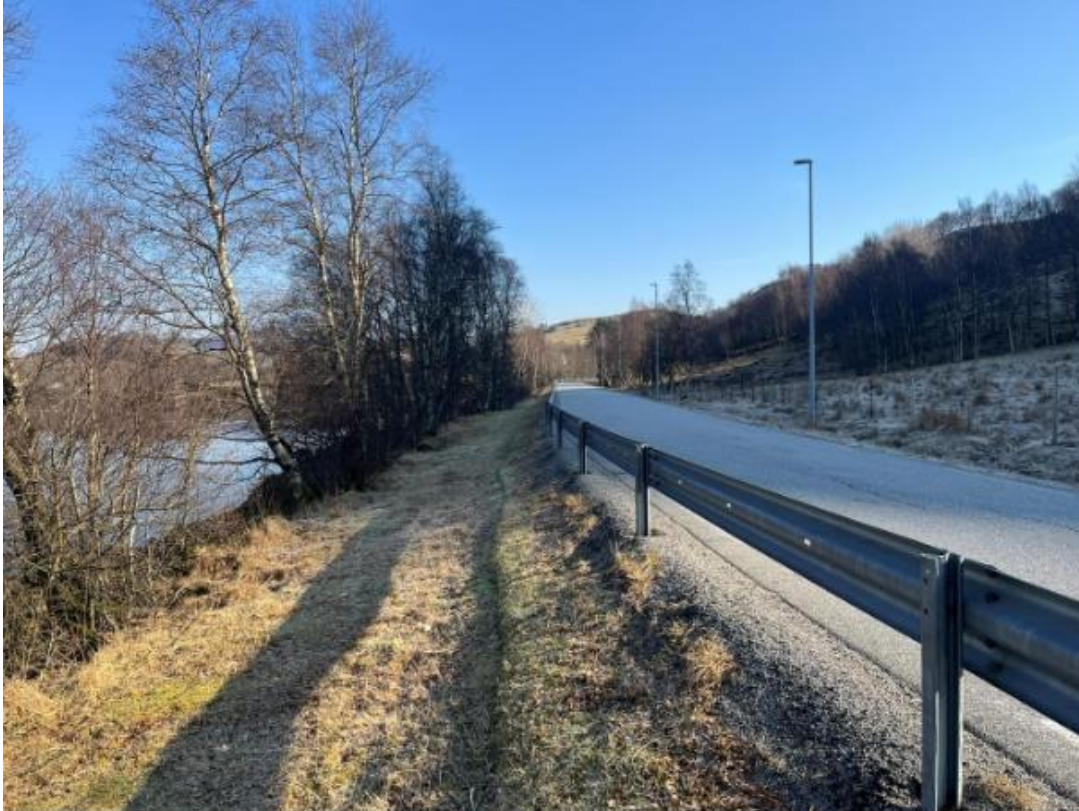
Bilde som viser eksisterende vei og kantsoner mot Edlandsvatnet.
