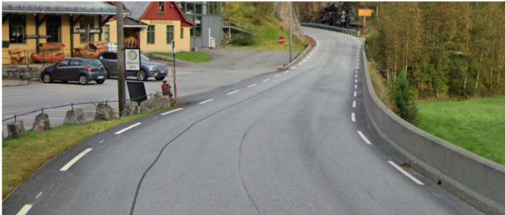
Figur 6: viser sikkerhetselementer langs Fv.450 forbi Byrkjedalstunet, retning nord
