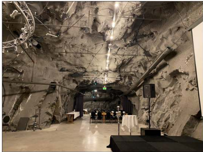
Figur 9 - Berghall. Sikret med sprøytebetong og bolter.
