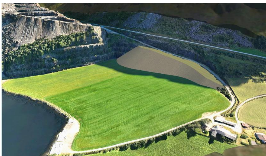
Figur 2-6 Visualisering av midlertidig lagring av masser - før tilbakeføring. Kilde: Mibau Stema Norge
