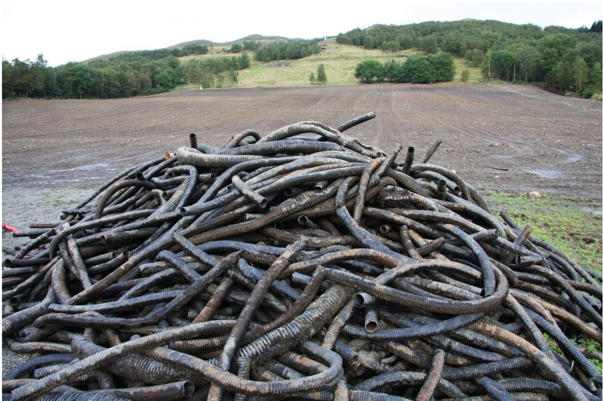
Fulldyrka jord over er grøftet på nytt. Gamle underdimensjonerte grøfterør er byttet ut med større.
