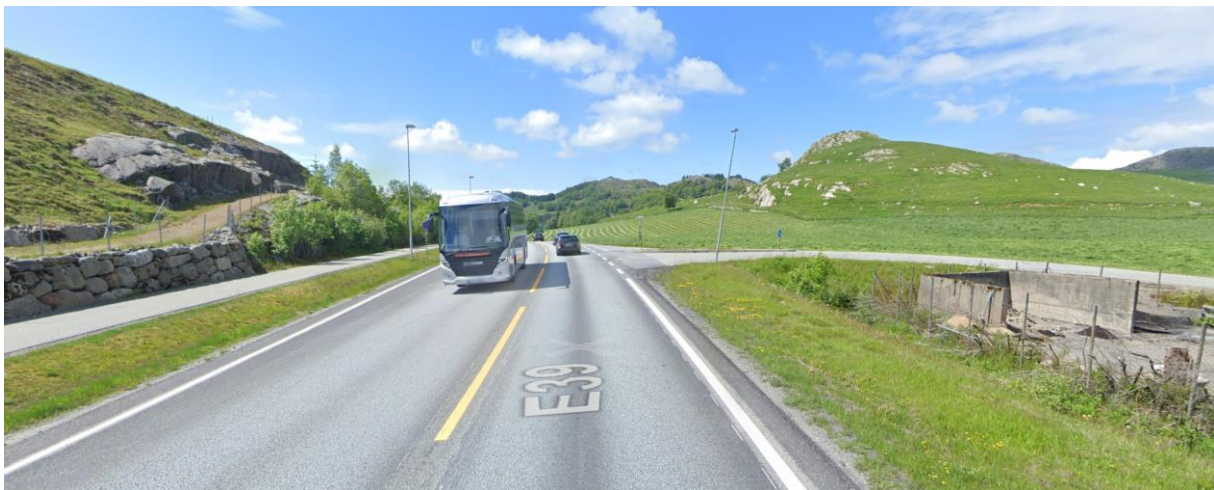
Figur 3 Bilde av dagens E39 og sideveg Øvrekluge inn til høyre.
