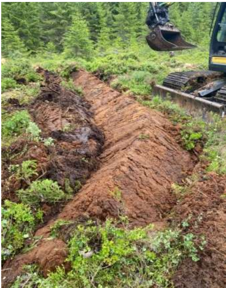
Figur 22 Eksempel på restaurering av myr. Tetting av grøfter med stedegen masse. Foto: Martin Skarpodde, Ragn Sells. Kilde: Miljødirektoratet, «Plan for restaurering av våtmark i Norge 2021-2025».
