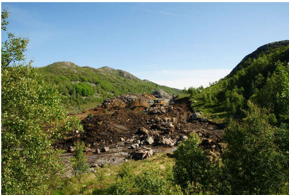
Figur 2 Opparbeiding av boligfelt i Kodlidalen. Foto: Reidun Solli Skjørestad
