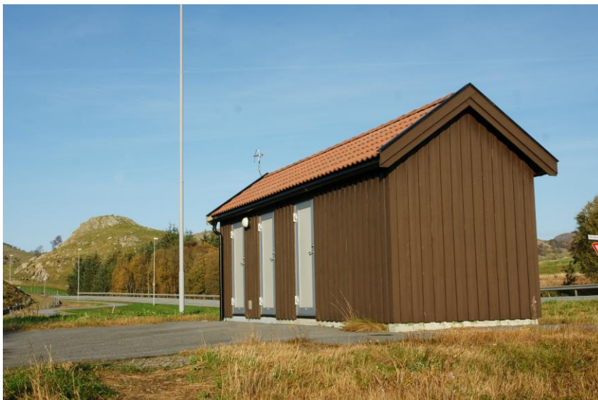
Kombinert vann og kloakkpumpestasjon på Bollestad.
