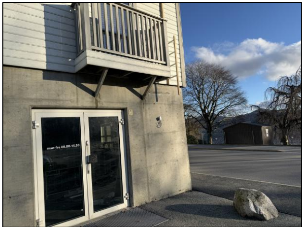
Figur 2-6 Eksisterende inngang for kontorlokale.
